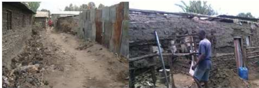
Picha na. 11: Ubomoaji wa hiari wa sehemu ya nyumba ya mkazi wa kitongoji cha Sakina kata ya Elerai jijini Arusha ili kuruhusu ujenzi wa barabara
