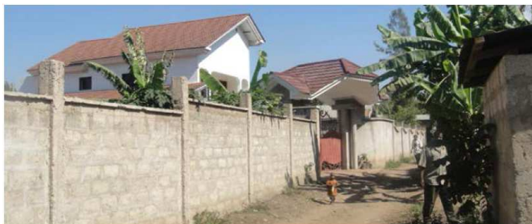
Picha na. 1: Nyumba ya kisasa iliyo katika eneo lisilo na miundominu jijini Arusha
